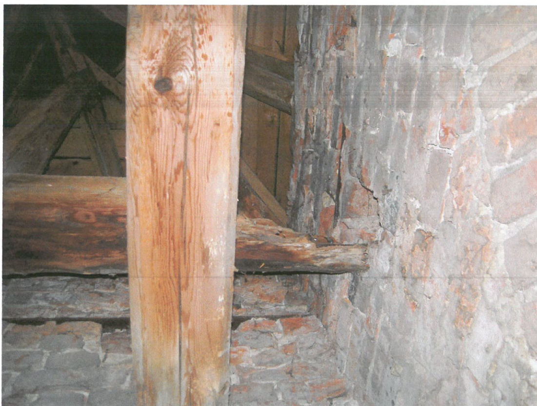
Na zdjęciu widoczny element nr 1 – belka drewniana 16x19 cm do wymiany – patrz rys. nr 2
