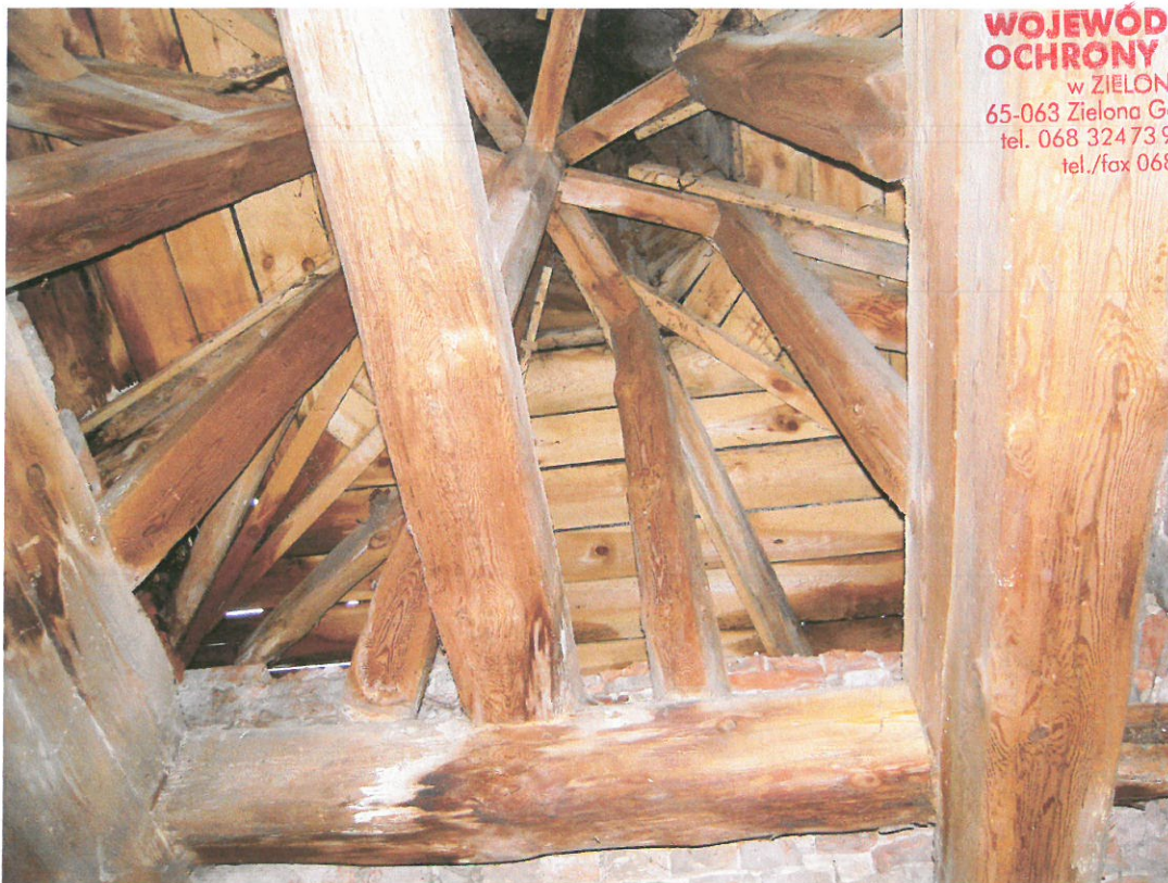
Na zdjęciu widoczny element nr 1 – belka drewniana 16x19 cm do wymiany – patrz rys. nr 2
